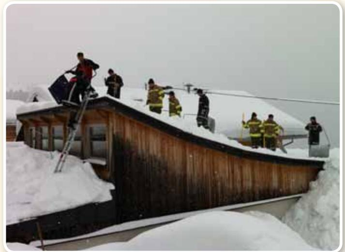
Dabei wurde festgestellt, dass die Dachkonstruktion unter der Schneelast bereits teilweise nachgegeben hatte. Um weitere Beschädigungen zu verhindern, und die Sicherheit für das Gebäude zu gewährleisten, schaufelte die Feuerwehr das gesamte Dach unverzüglich ab.
